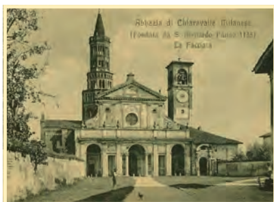
La facciata dell'Abbazia, ancora in forme barocche, antecedenti il restauro
